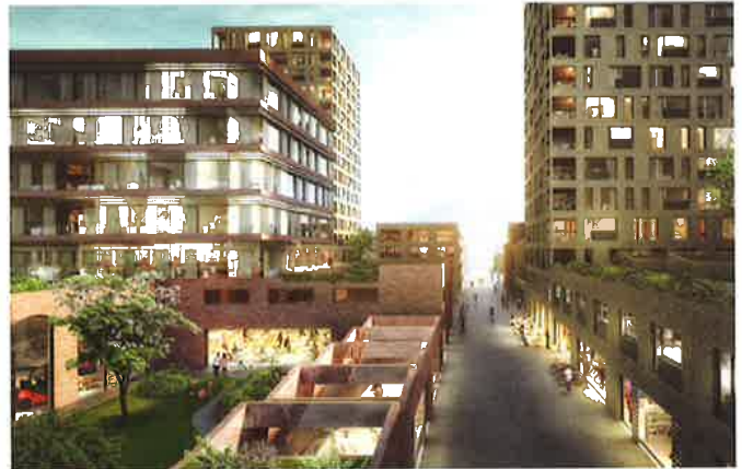
Blick entlang der Pressgasse Richtung Zugersee
